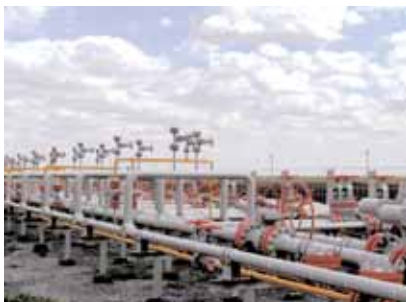
Подключение дополнительных скважин IV очереди на Оренбургском нефтегазоконденсатном месторождении
