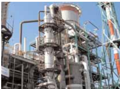
Восстановление и модернизация мощностей гелиевого завода
