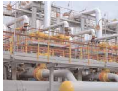
Реконструкция технологических объектов Оренбургского газоперерабатывающего завода
