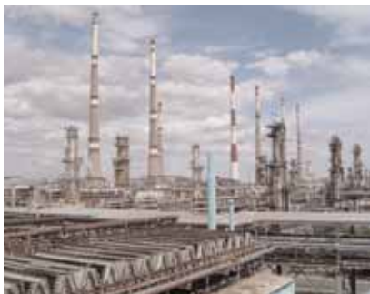
Расширение производства № 3, 6 по переработке газового конденсата на Астраханском газоперерабатывающем заводе
